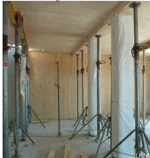
Sichtbare Unterzüge und Holzstützen
