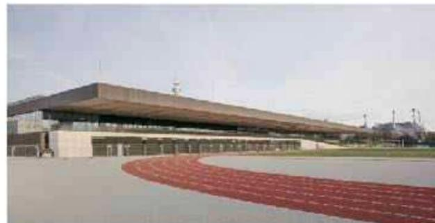
Das 18 Meter stützenfrei auskragende Wanddach aus Holz prägt die Optik des neuen Campus. Foto: © Aldo Amoretti
